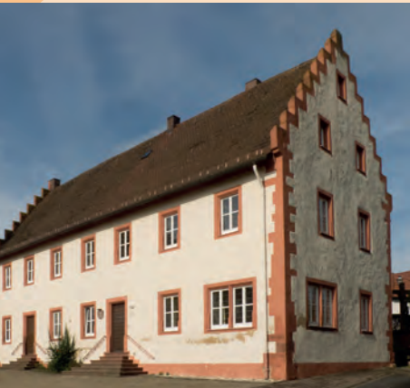
Treppengiebelhaus (alte Probstei)
