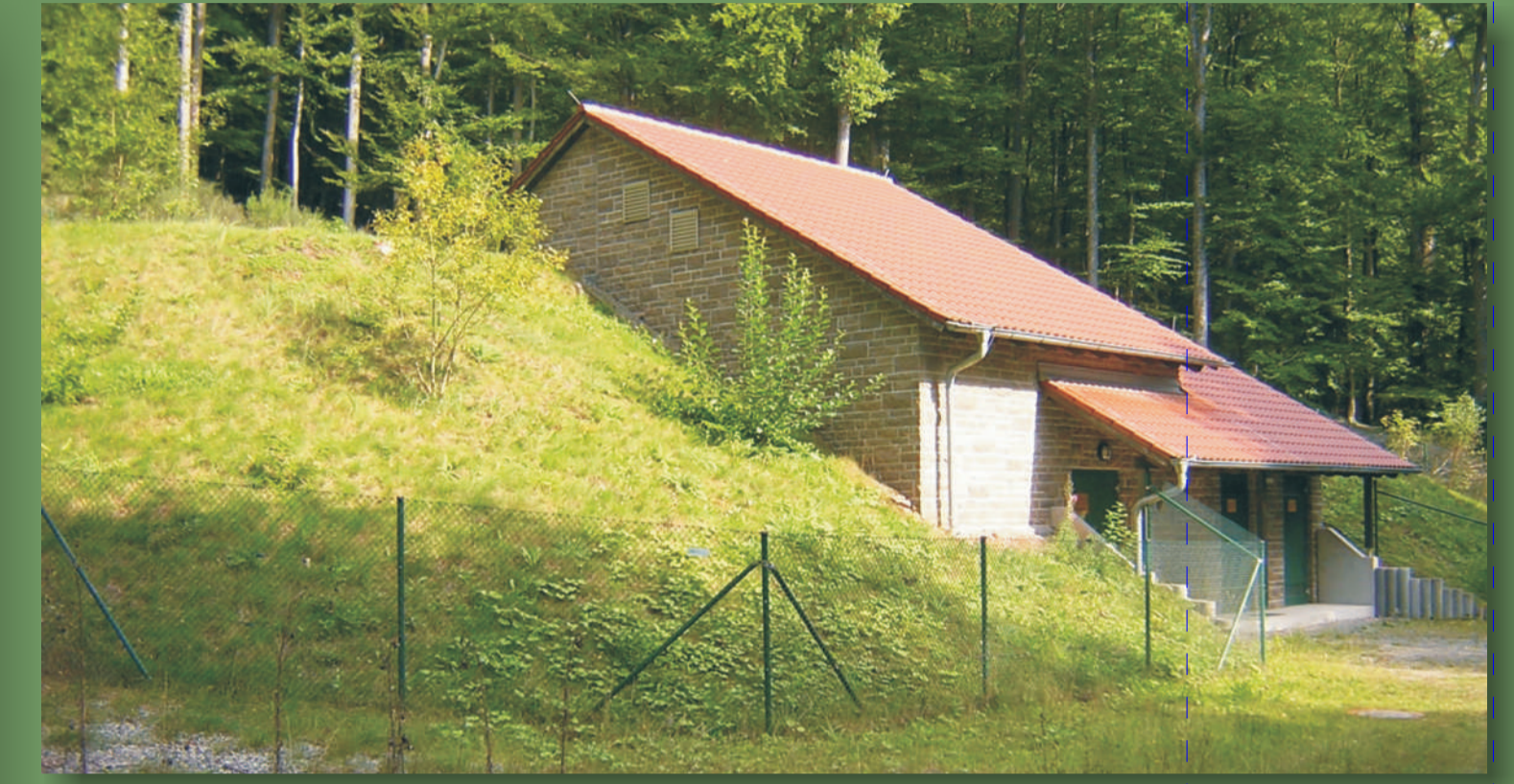
Hier wird das Grundwasser aus den Brunnen gemischt.
